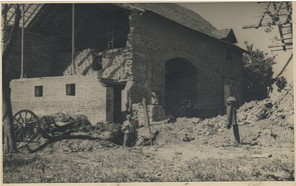
Die Schäden des Bombentreffers waren erheblich. Zum Glück blieb es beim Sachschaden.
